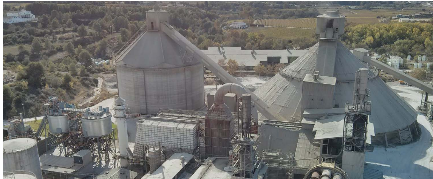
Silos de cemento. Centro productivo de mortero de Monjos, en Barcelona.
