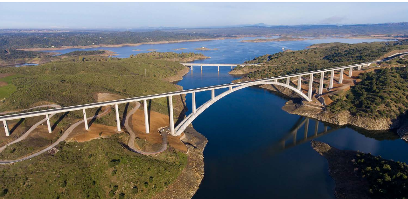
Viaducto Río Almonte, España.
