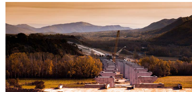
Montaje de vigas en viaducto autovía A21.
