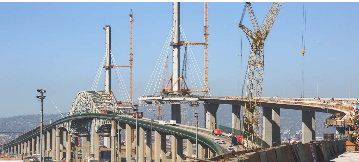
Puente Gerald Desmond, EE. UU.
