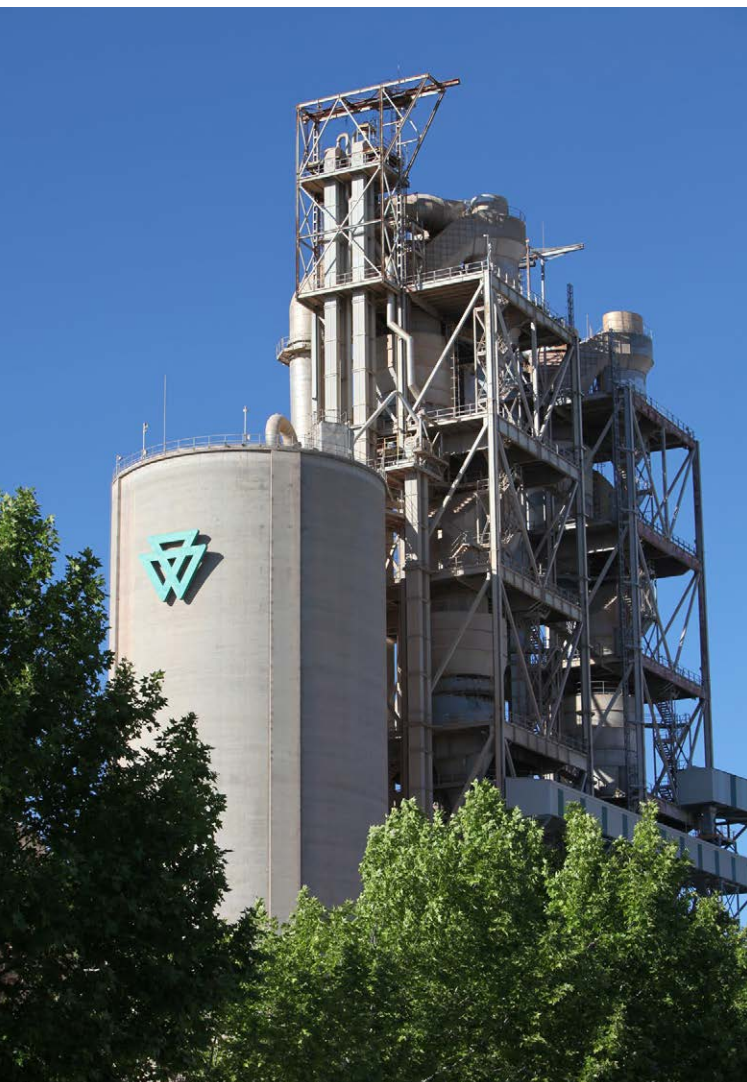
Torres de ciclones. Centro productivo de cemento de El Alto, en Madrid.
