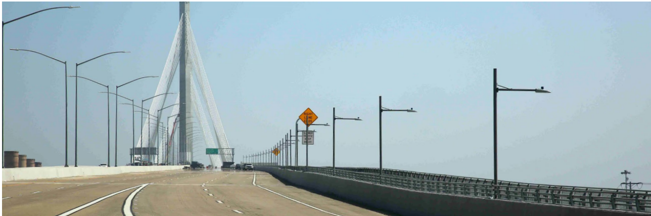
Gerald Desmond Bridge, Los Angeles (USA).
