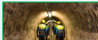
Mantenimiento del alcantarillado
