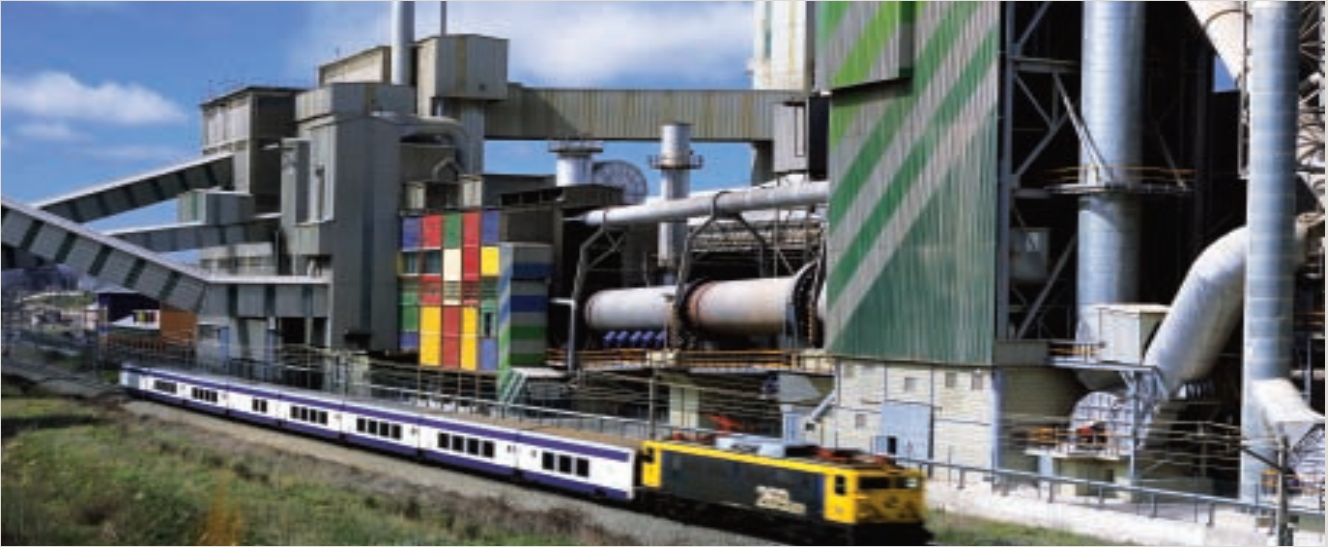
Factory in Mataporquera. Cantabria
