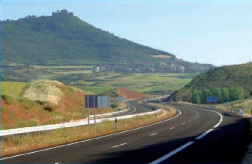
Autovía del Camino dual carriageway. Pamplona-Logroño section
