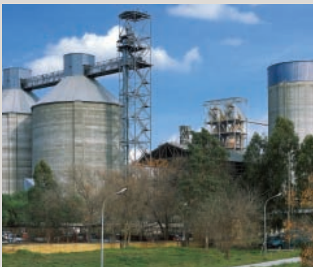
Factory in Alcalá de Guadaíra. Sevilla
