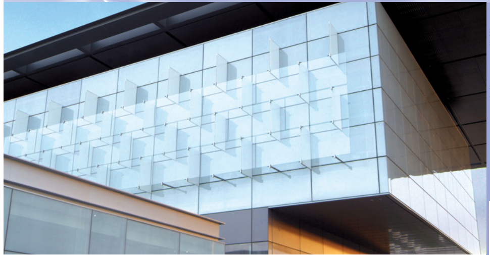
Telefónica Communications City. Las Tablas. Madrid
