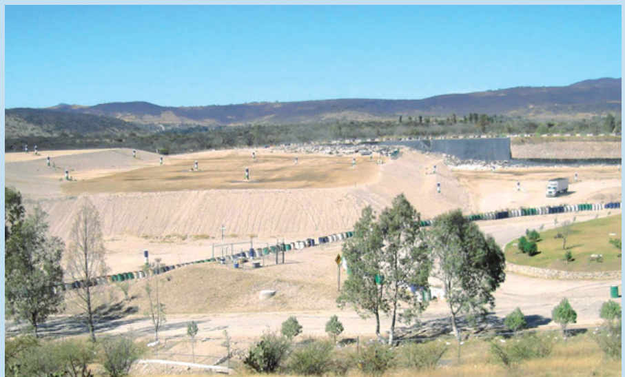
Landfill in Querétaro. Mexico.
