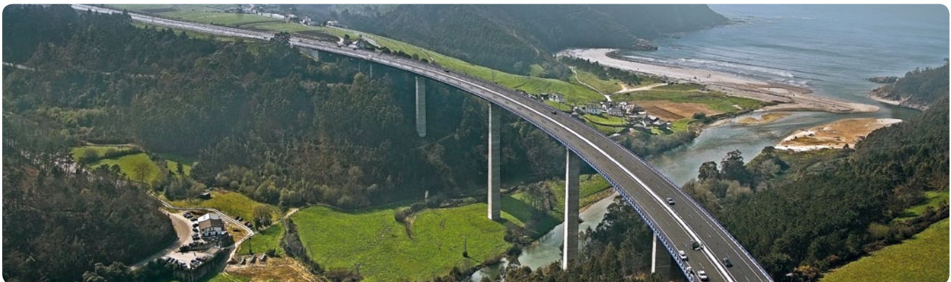
CANERO BRIDGE, ASTURIAS.
