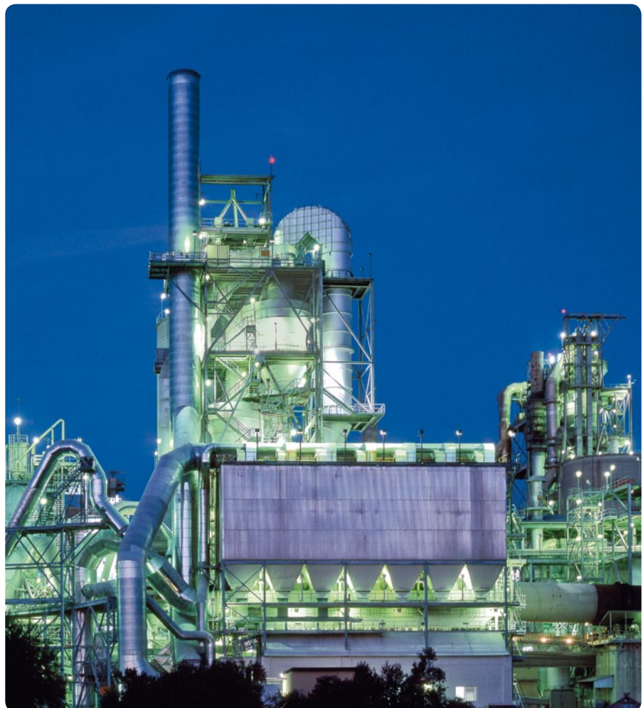
EL ALTO CEMENT FACTORY, MADRID.
