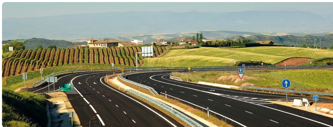
AUTOVÍA DEL CAMINO DUAL CARRIAGEWAY, NAVARRA.
