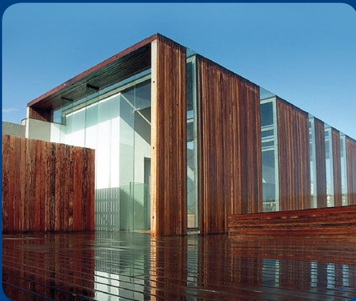
REFURBISHED CITY HALL, LAS PALMAS DE GRAN CANARIA.
