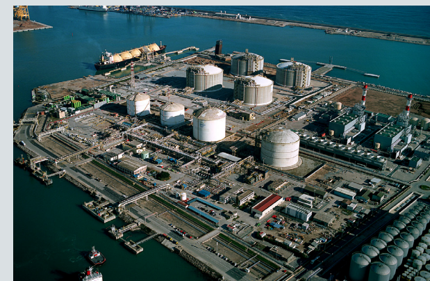
Enagás plant, Barcelona
