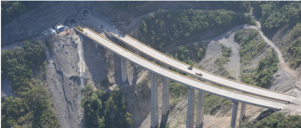
San Marcos Viaduct. Nuevo Necaxa-Ávila Camacho Motorway (Mexico).
