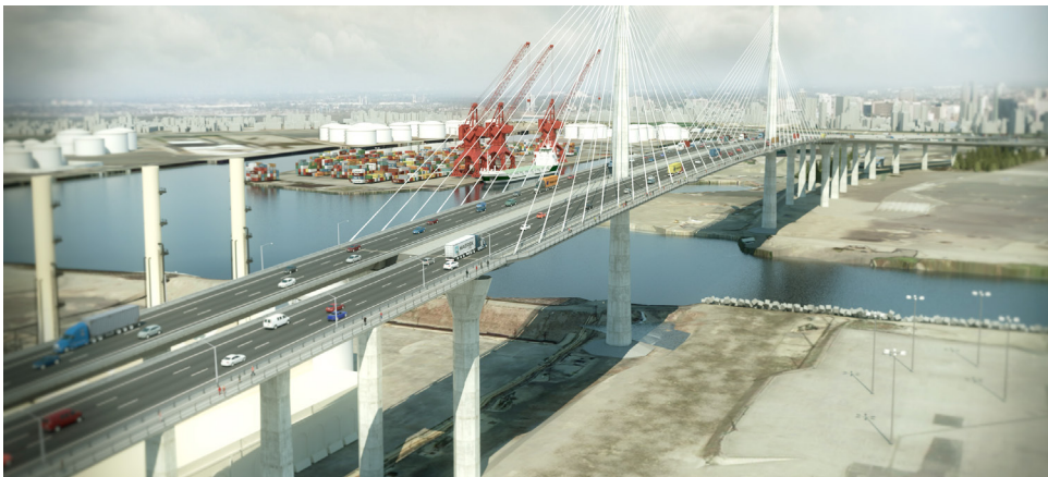
Gerald Desmond Bridge. Los Angeles (USA).
