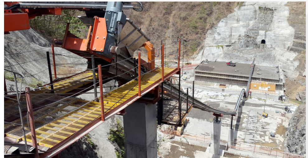
Chucás Dam (Costa Rica).
