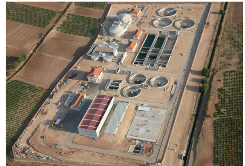
Wastewater treatment plant in Tomelloso, Ciudad Real
