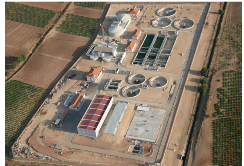
Wastewater treatment plant in Tomelloso, Ciudad Real
