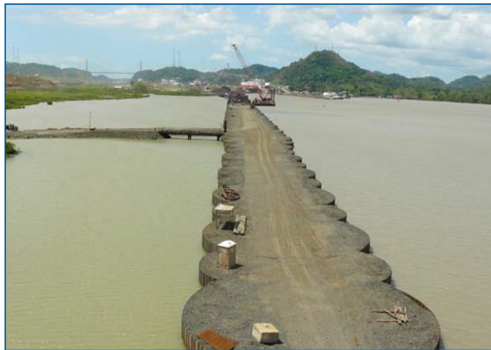
Construcción del acceso del cauce del Pacífico en el Canal de Panamá
