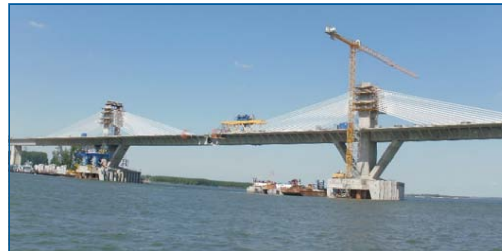
Puente Vidin-Calafat (Bulgaria-Rumanía)
