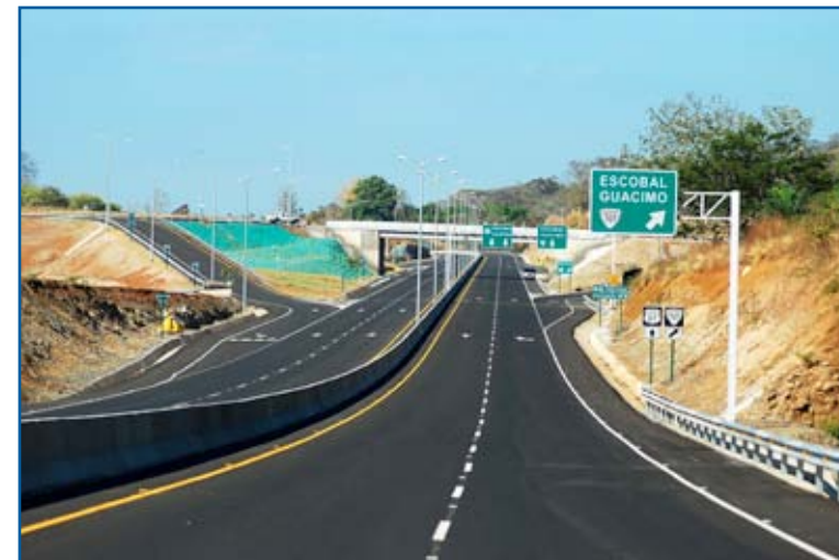
Autopista San José Caldera, Costa Rica
