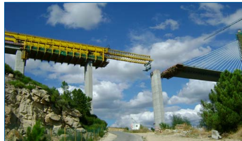
Cimbra NRS MSS 60 en el viaducto del Corgo (Portugal)
