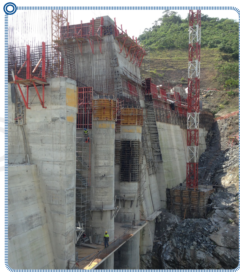
Bajo Frío Dam in Panama
