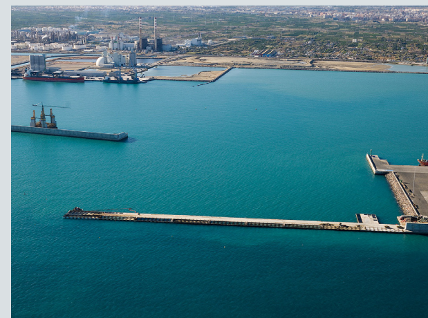
Dique este puerto de Castellón
