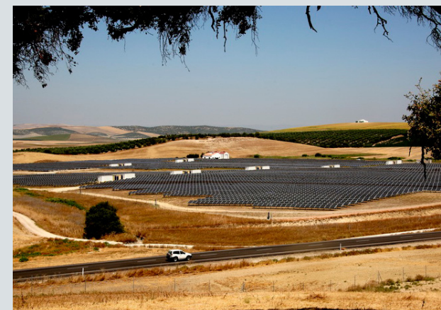
Planta fotovoltaica en Córdoba
